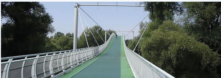
Obr. 12 Pohľad na dokončený cyklomost Slobody
